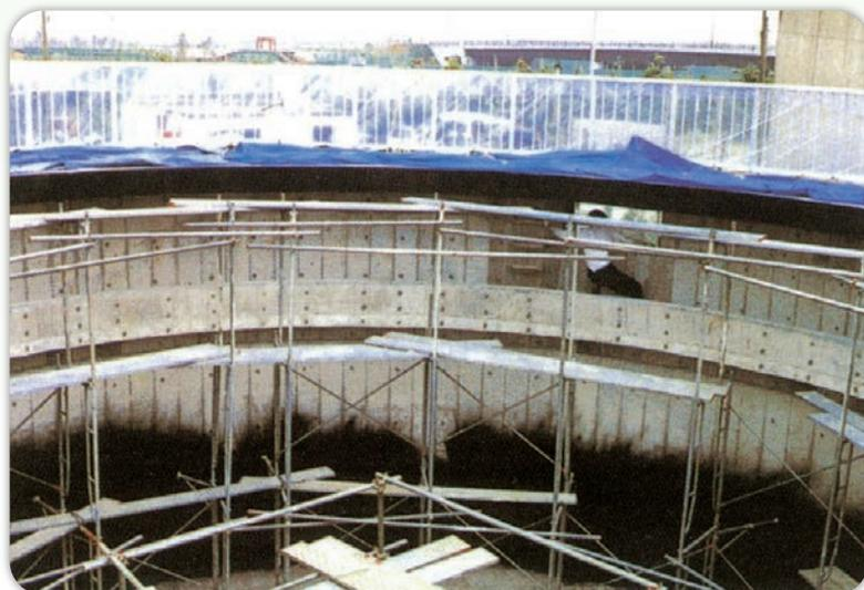
●市営終末処理場 新設汚泥タンクにA：QW塗布作業中
